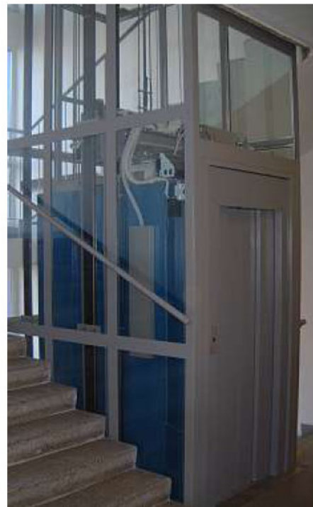
Šachta výtahu po regeneraci
